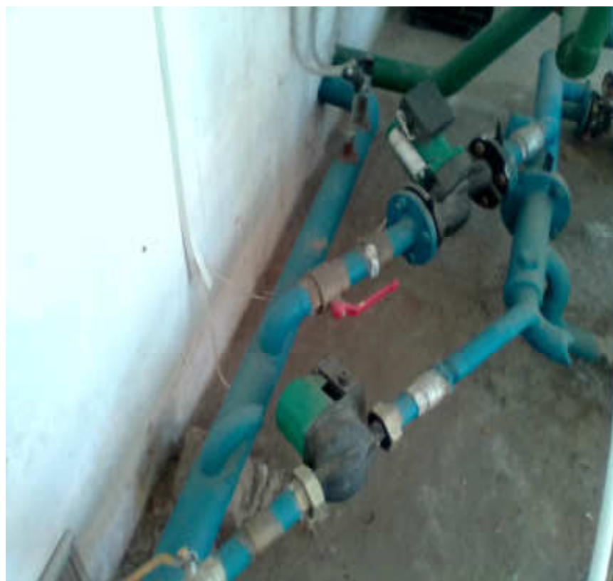
Видимое изображение №2 Обвязка насосов
