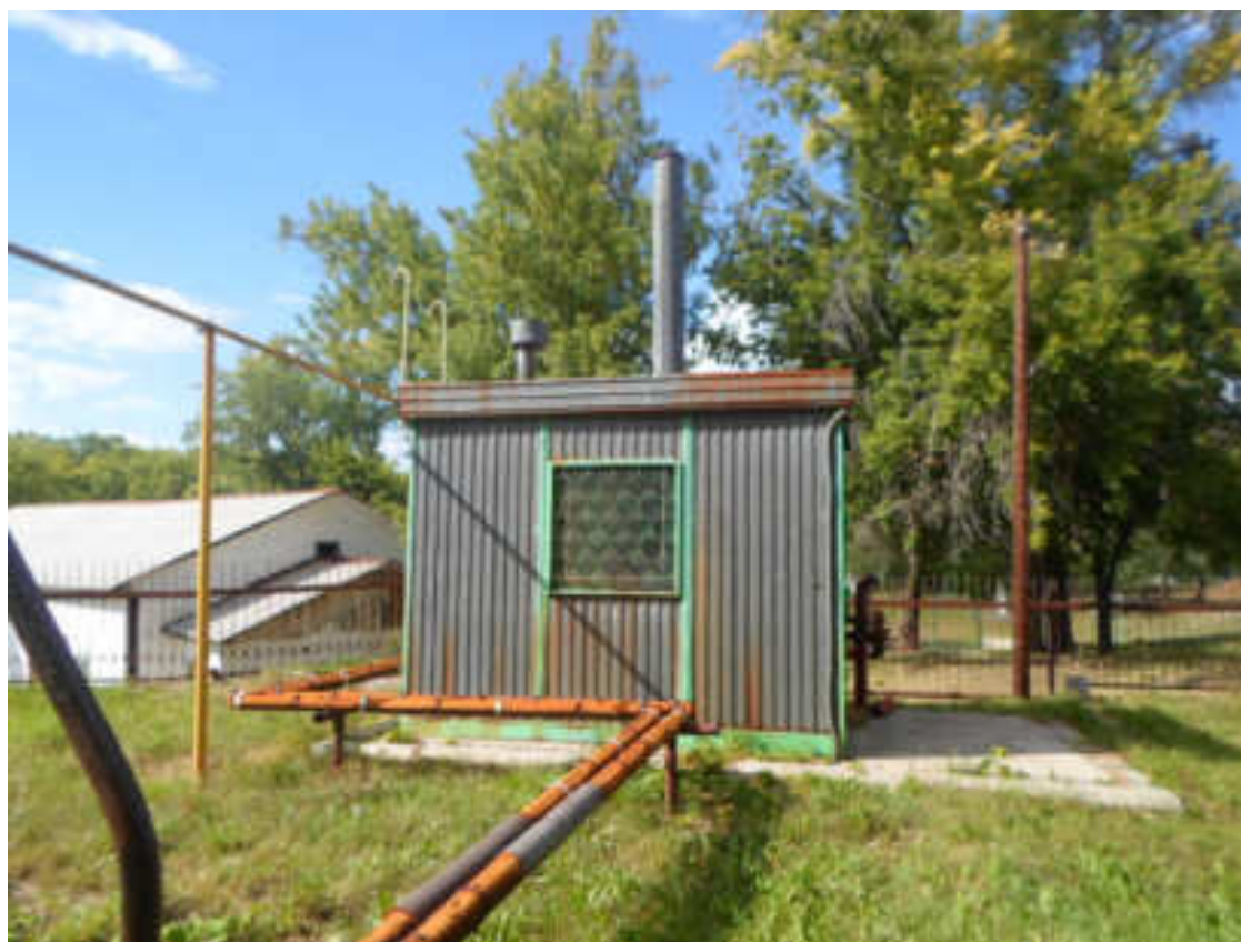
Видимое изображение №1 Внешний вид котельной
