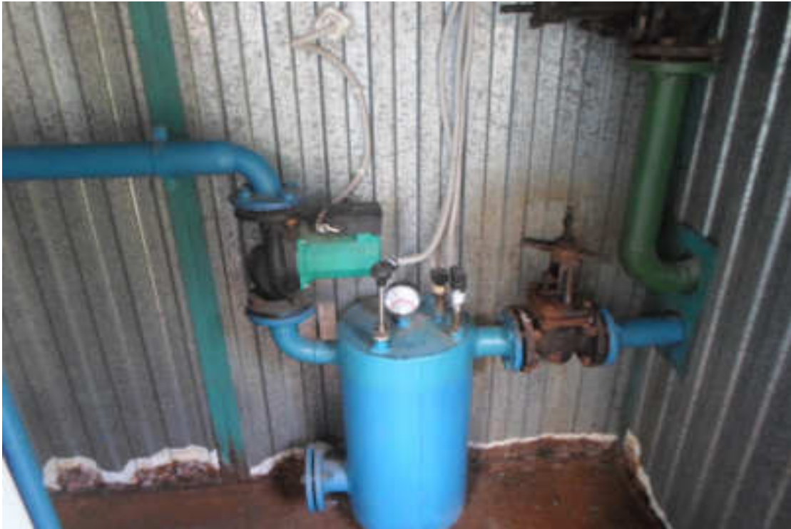
Видимое изображение №2 Обвязка насоса
